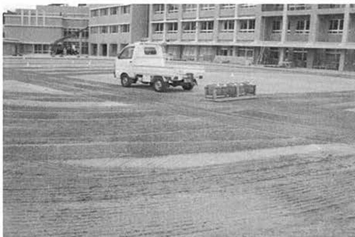
図8-4 軽車両でのほぐし(重量調整 有・爪部突出)
